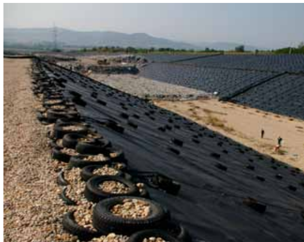
A sajkázai lerakó építés közben
