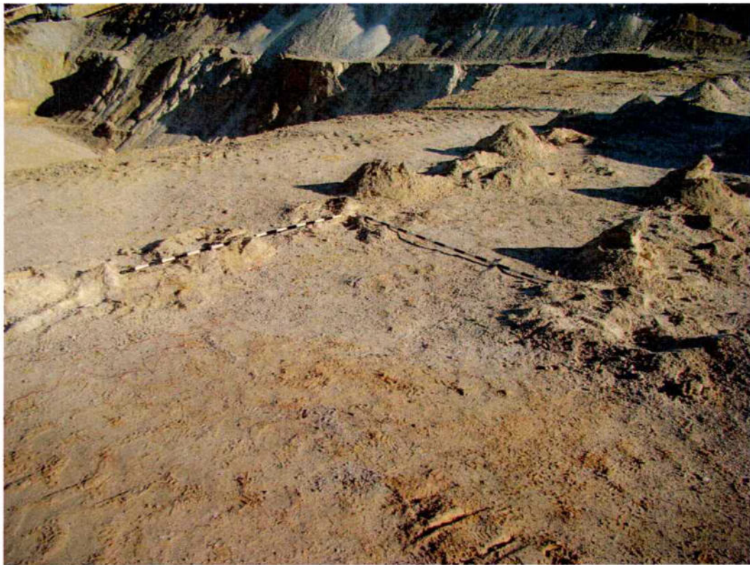
A lyuktelepítés méretei a 0,1 m-es beosztású rudakkal ellenőrizhető
