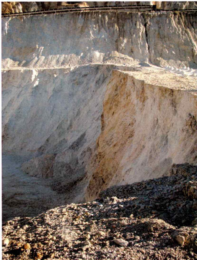
A robbantási front homloka (szintmagasság: 14 m)
