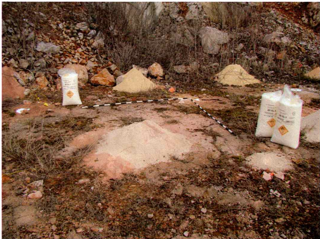
A robbantólyukak kiosztása (W=3.5 m; E= 3.0 m)
