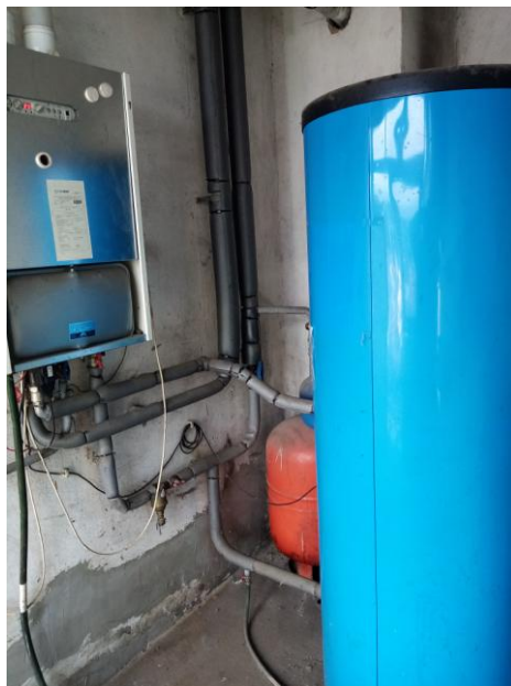
6. ábra: 34,6 kW névleges bemenő hőteljesítményű földgáz üzemű kazán
