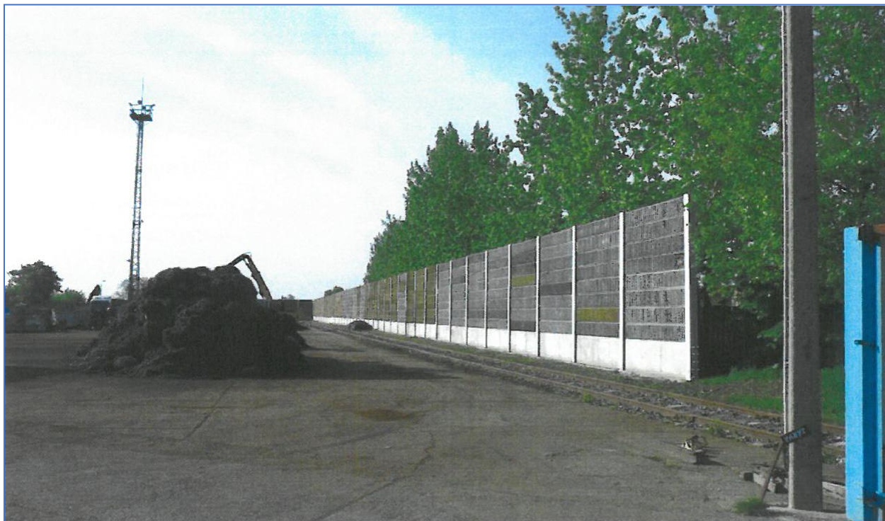
12. ábra 2014-ben elkészült 5 méter magas zajvédő fal
