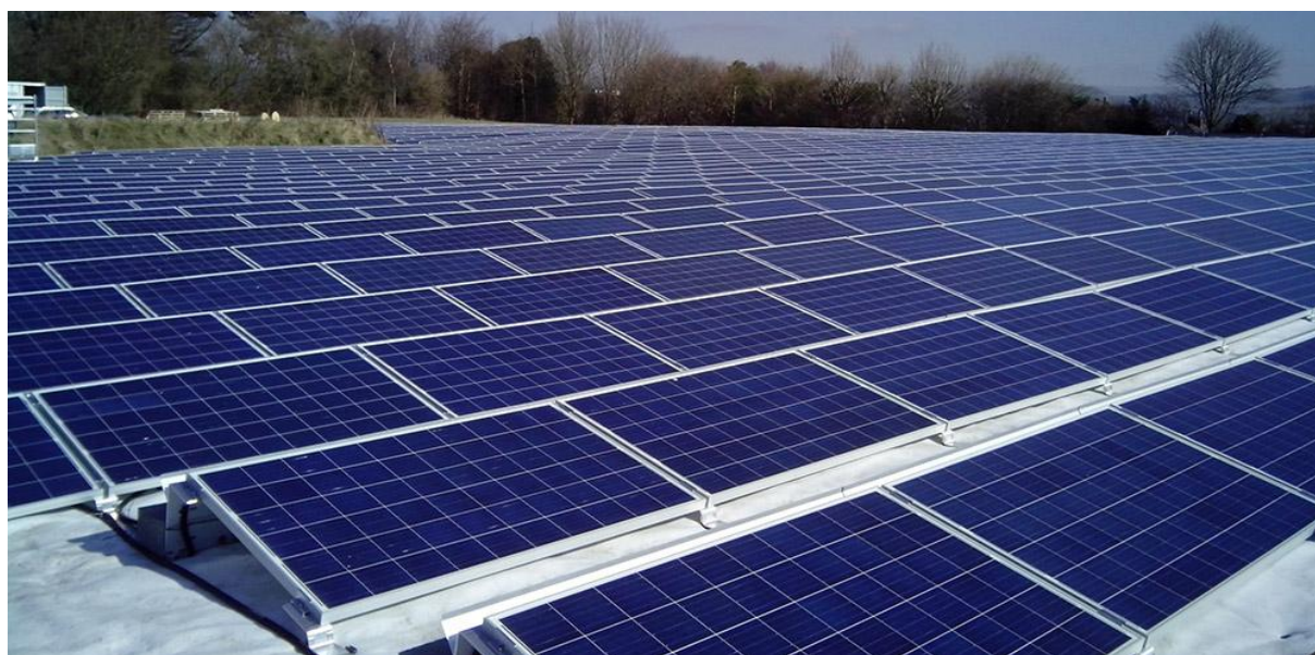
2. ábra: Napelem-modulok rögzítése (minta)
