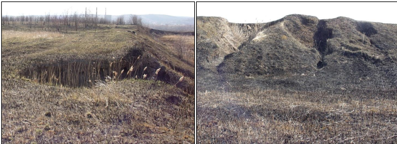
22. fotó: V/2 kazetta északnyugati szegélyének töltésében kialakult suvadás (oldal- és előlnézet)
