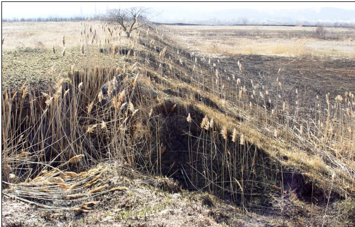
24. fotó: V/2 kazetta északi szegély töltésében benádasodott suvadás
