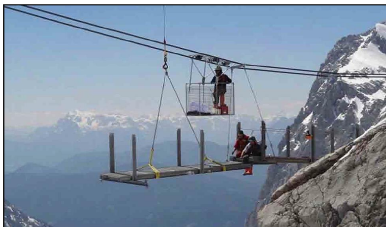
8. sz. ábra: A hídpálya-elemek összeállítása szerelőkosárból
