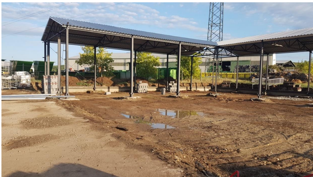
4. ábra: A fedett gépszín csarnok állapota az első építkezési ütem végén (2018.)
