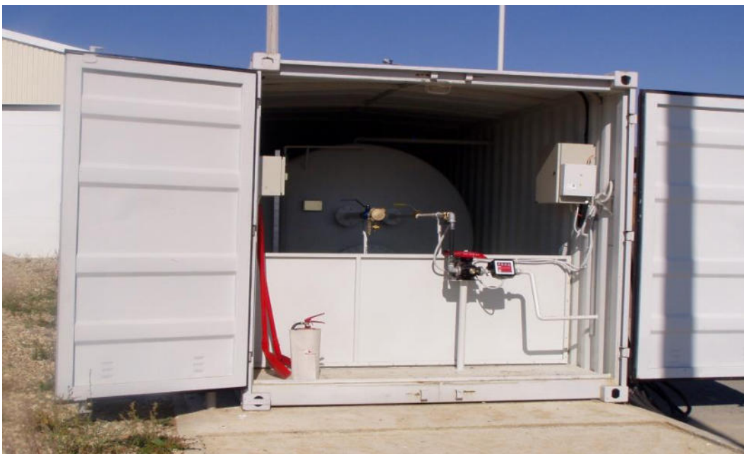
7. ábra: Az üzemanyag tároló tartály, előtte a konténerházhoz folyadék-tömören kapcsolódó acél válaszfallal, illetve a szerelvényekkel
