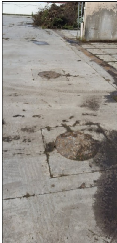
4.3 kép: Csurgalékvíz gyűjtő tartályok fedlapjai
