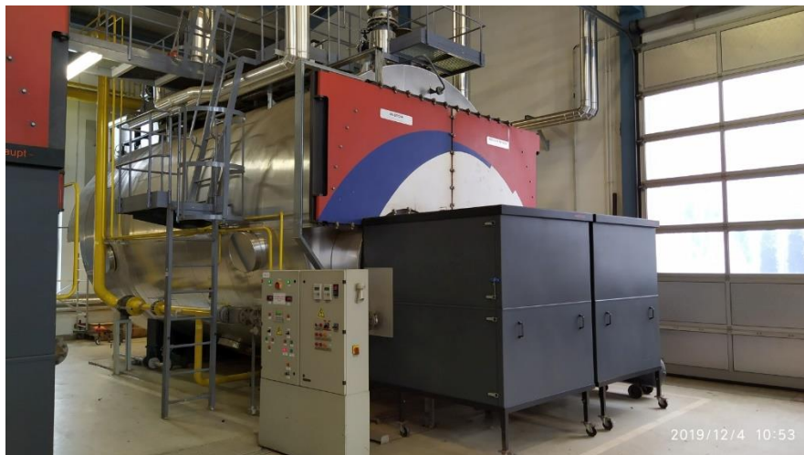
4.1. kép: ALSTOM forróvíz gázkazán
